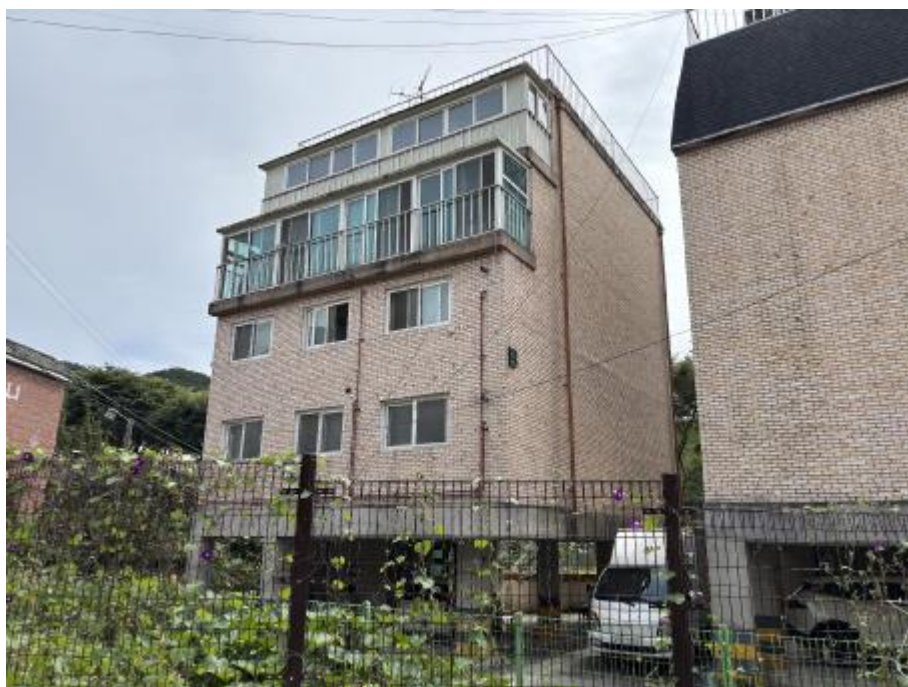
일련번호(가),(나) 건물 전경(통칭 영진빌라트 B동)
